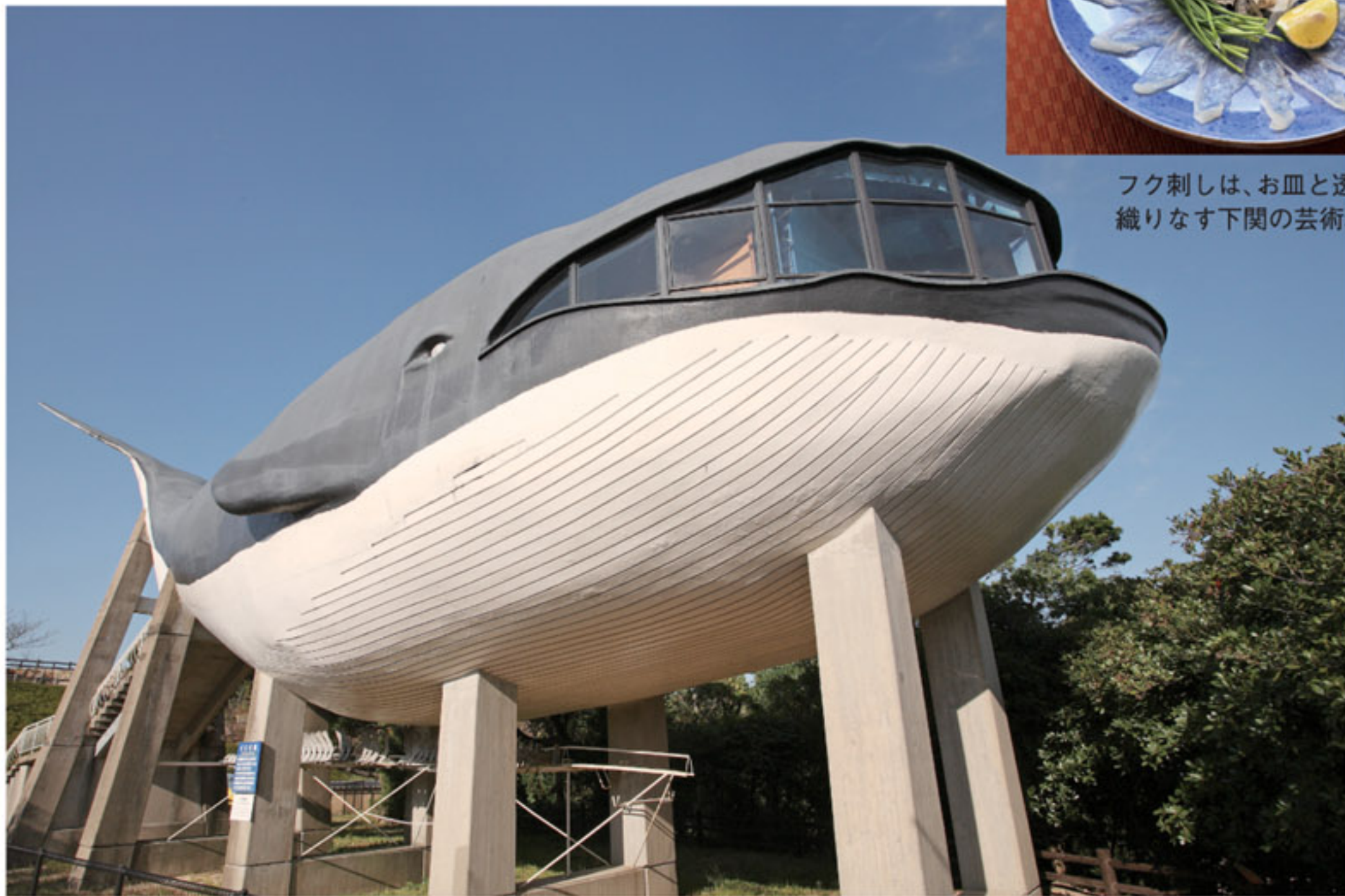
昭和33年(1958)に完成した「くじら館」。体長25メートル、体重130トンのクジラを実物大に模している。どのように造形したのかは、建築業界の謎とか
