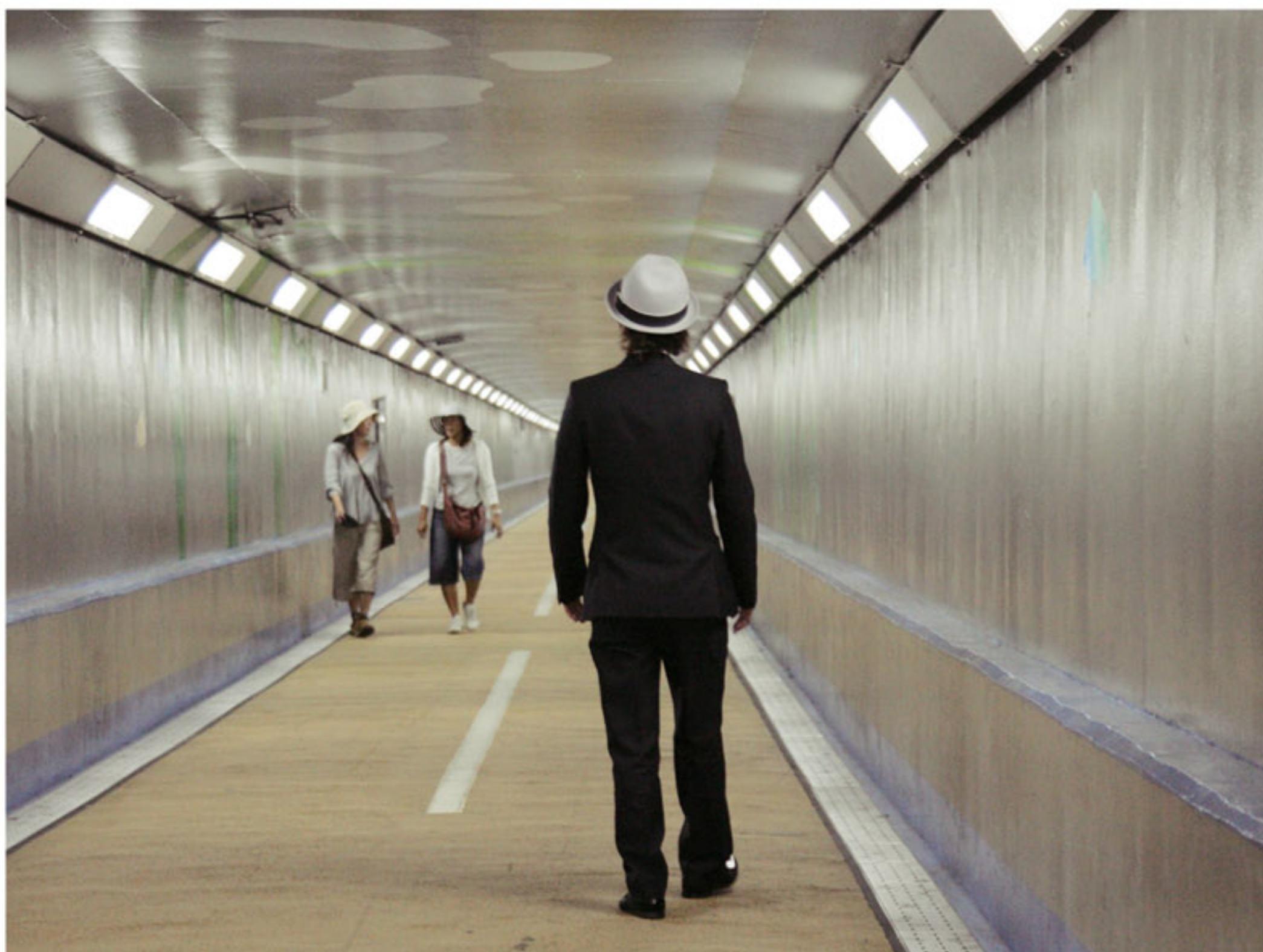
関門トンネル人道へは、エレベーターで地下約60メートルおりの。入場時間は午前6時～午後10時。 通行無料、自転車は片道20円。道幅4メートル。オツな海底散歩が楽しめる
