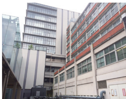
耐震リニューアル工事に25億円
