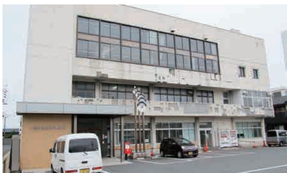
老朽化している安岡公民館
