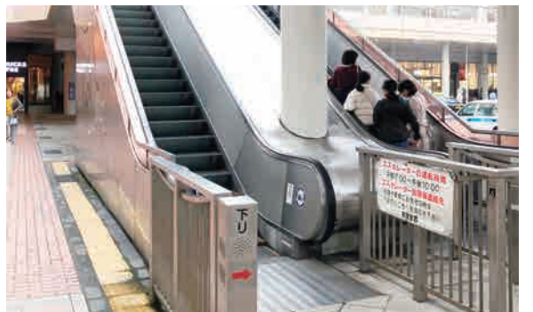
撤去予定のエスカレーター
