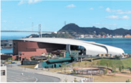
長寿命化工事が進行する海響館
