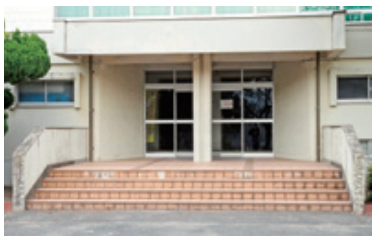
スロープが未整備の体育館入口
