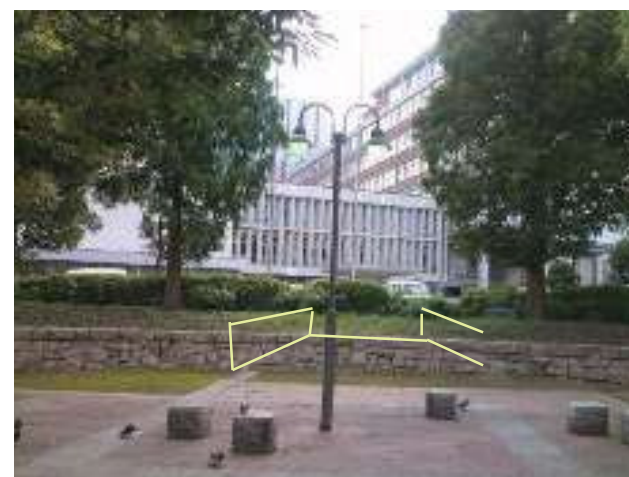
既存石積みの一部を撤去移設し、高低差を解消する
