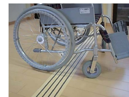
段差をなくした建具の選定を行う
