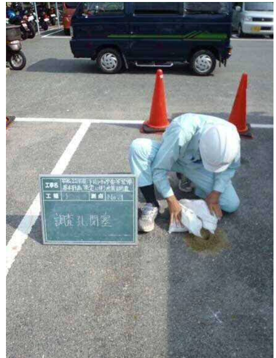
孔内閉塞状況
