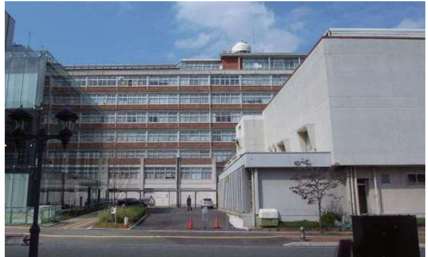
現況南側立面写真
