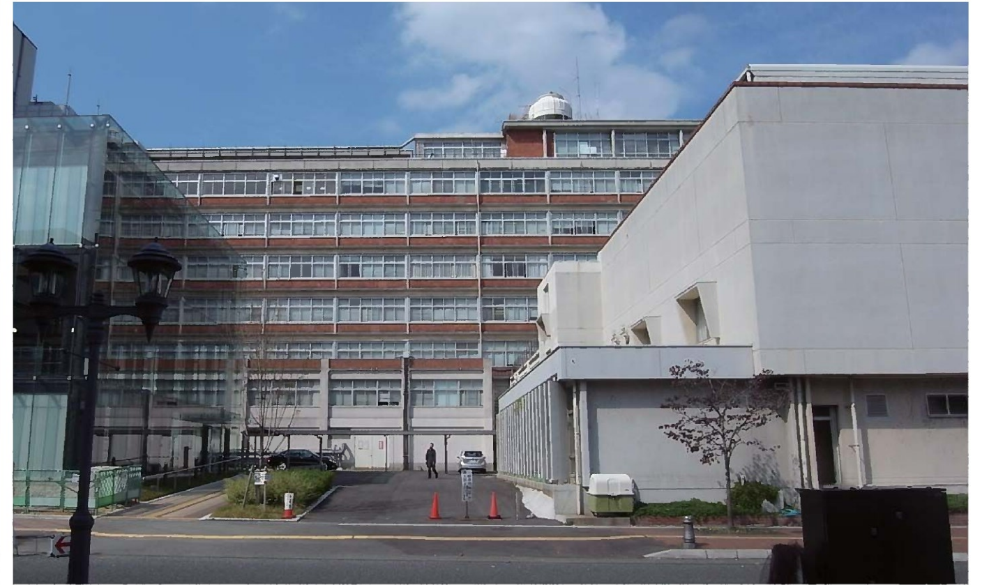
現況南側立面写真
