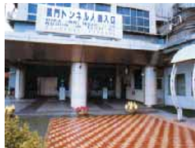
関門トンネル人道
