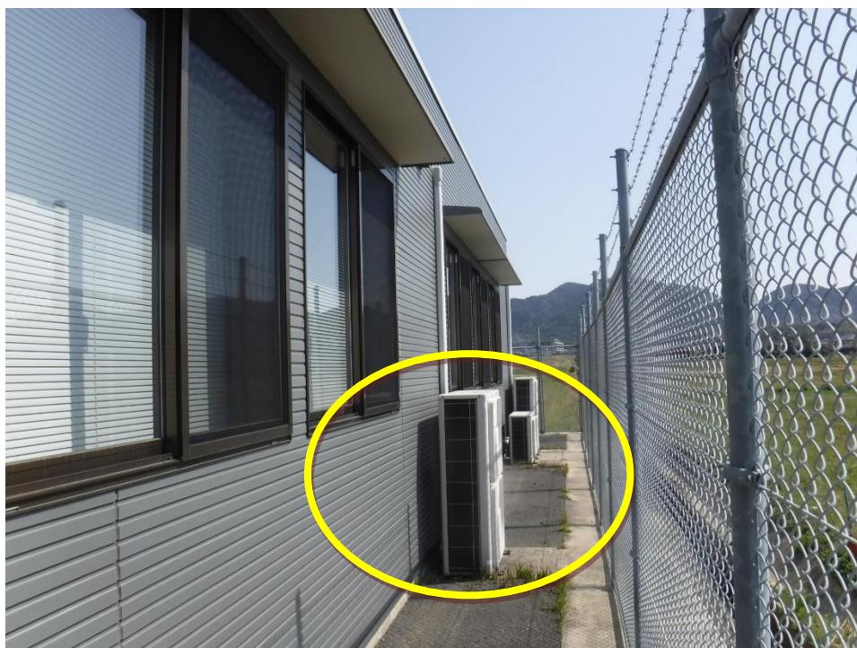
事務室既設室外機設置場所(写真②)
