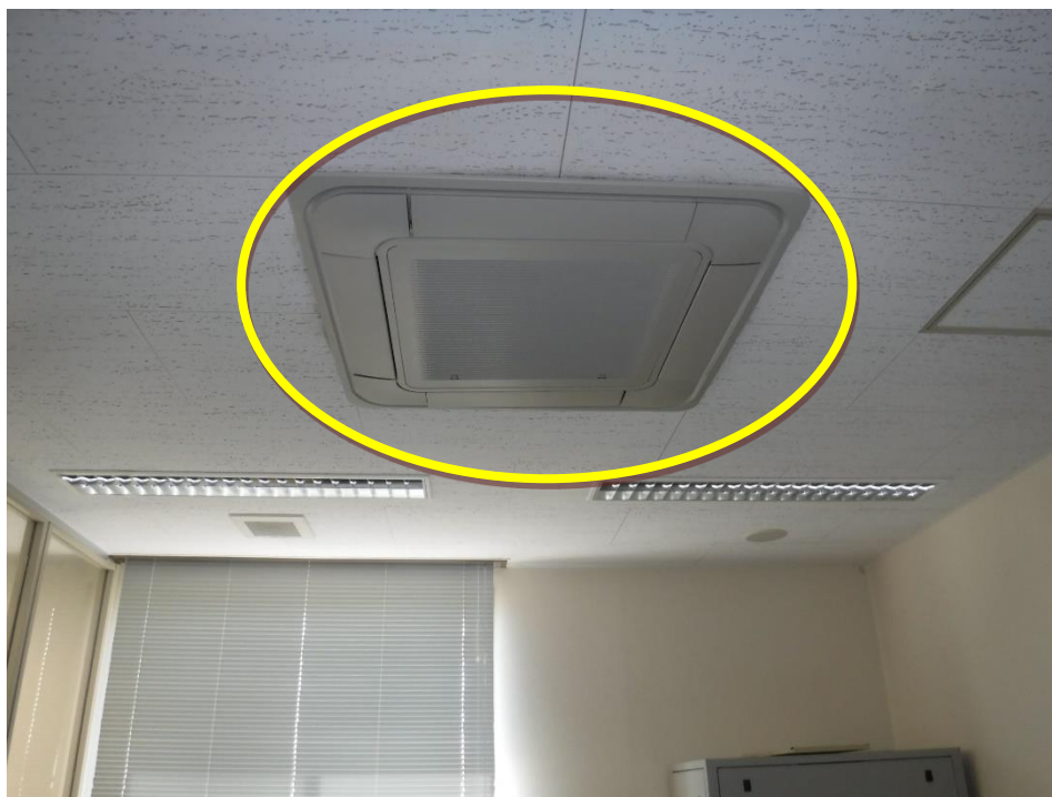
中央監視室既設空調設備設置場所(写真③)
